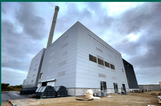
Biomasseværkets nye blok med kedel 3 og 4 starter produktion i december. Anlægget ligger på Endelavevej 7.
